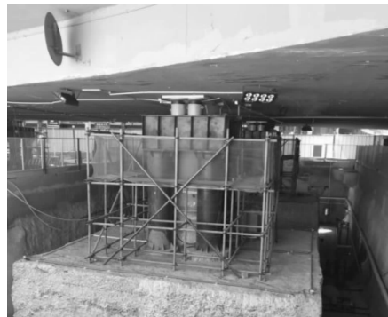
图4 预支顶现场施工图
