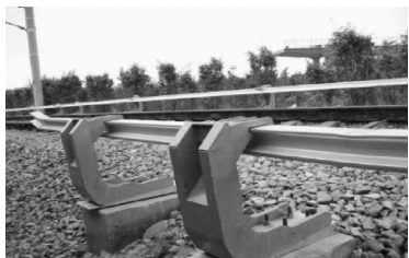
图7 第三轨供电系统端部弯头
