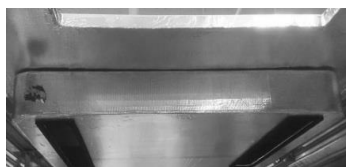
图7 风道上部进风口压接密封
